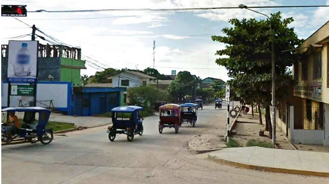
Ilustración 20: Vista del Jr. Aguaytía con la Tupac Amaru, la vía carece de veredas
