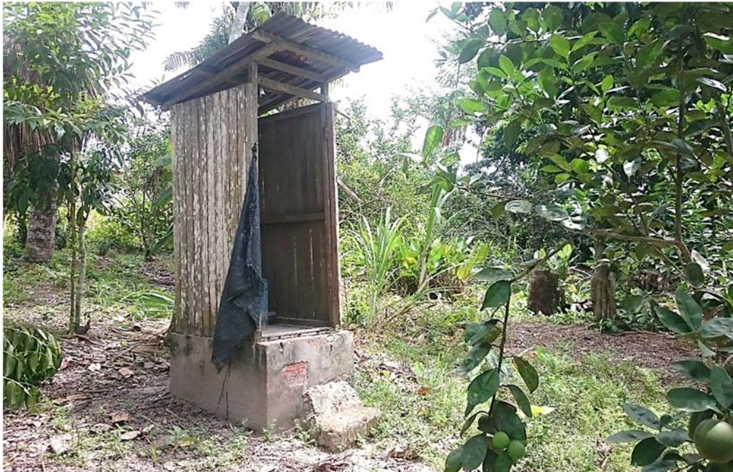
Ilustración 11: Vista de letrina en el caserío San Jose – Campo Verde
