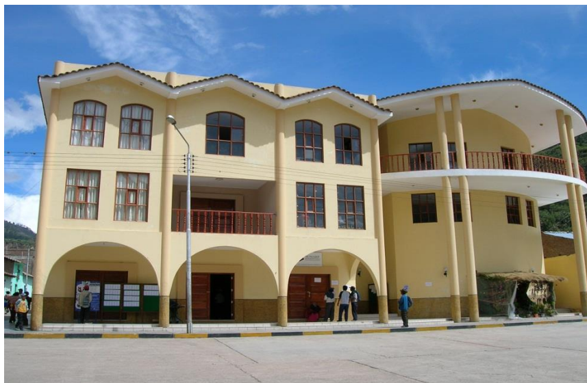
Fotografía Nº 04: Frontis del Palacio Municipal de la Provincia de Cangallo.
