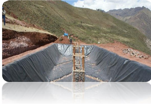
Vista fotográfica: Relleno sanitario con sistema de segregación
