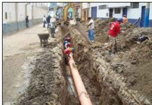
Imagen 08: Instalación de servicios básicos.
