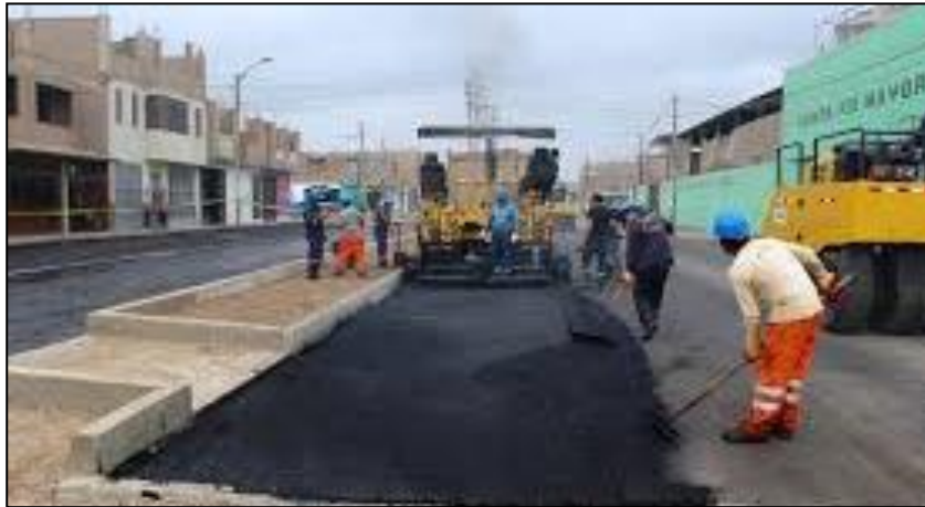
Imagen 10: Ejecución de obras para el mejoramiento del ornato.
