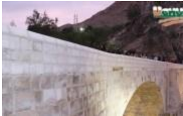
Puente San Pedro
