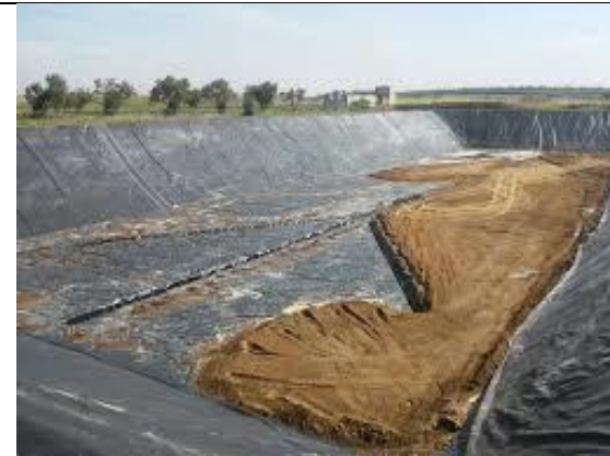
INSTALACION RELLENO SANITARIO - CELDAS TRANSITORIAS
